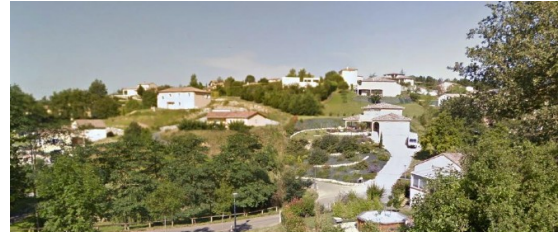
Implantation de bâti sur les crêtes et dans les pentes, sans intégration
